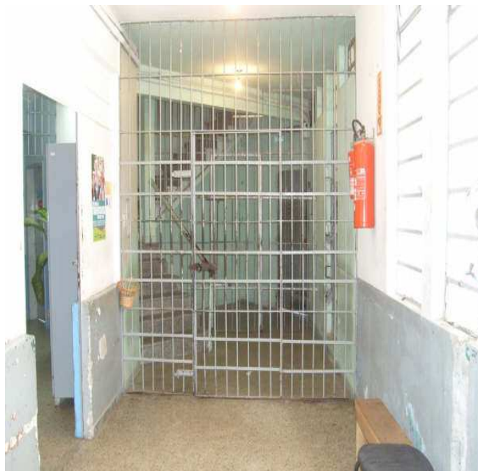
Foto 5 – Foto da entrada das Galerias A (embaixo), e Galeria D
