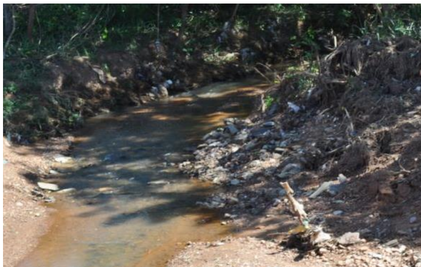
Figura 01 – Resíduos da construção civil à margem de córrego
