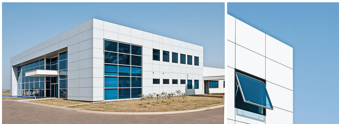
Figura 3: Fachada ventilada com revestimento Laminum (porcelanato técnico), da fabricante brasileira Eliane
