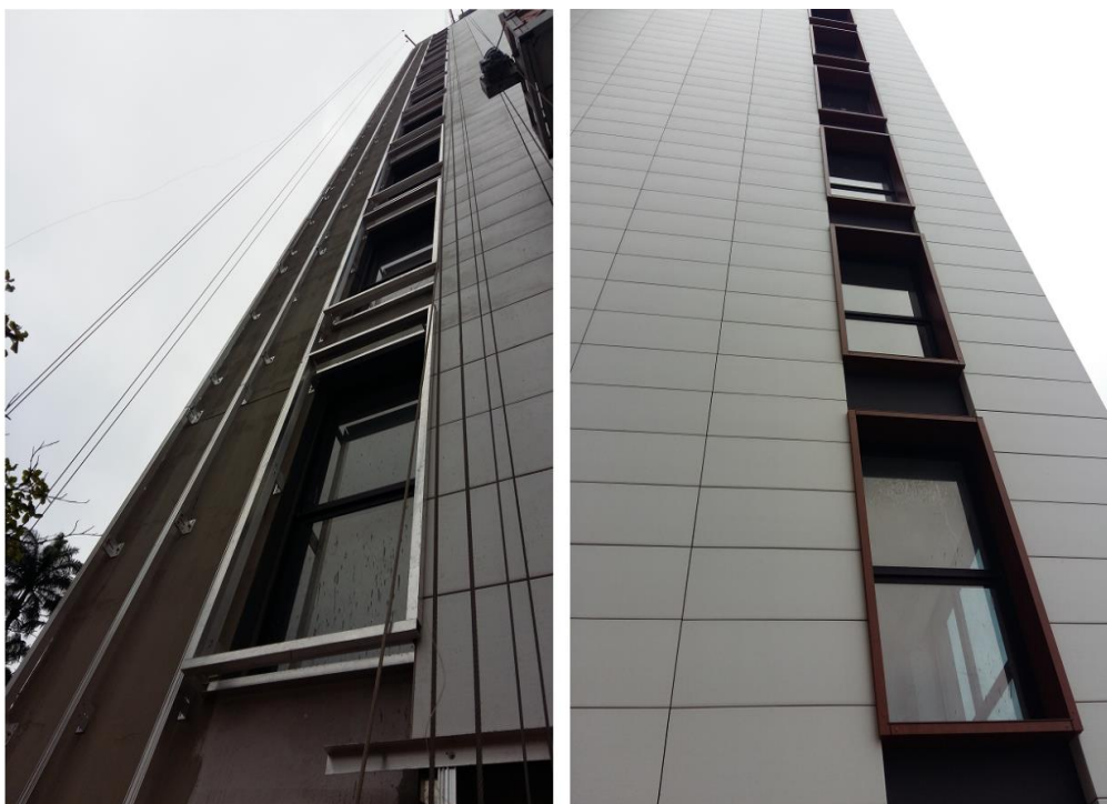
Figura 9 - Aplicação do revestimento externo de cerâmica extrudada
