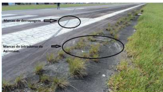
Fotografia do local da ocorrência e marcas da derrapagem
