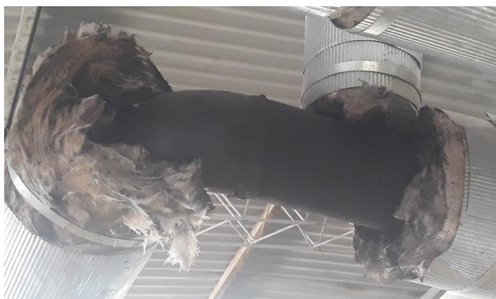
Figura 5 – Situação atual do isolante tipo lã de vidro.
